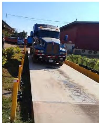
25 de enero: Realizamos verificación de balanzas de alto alcance o “camioneras” en la provincia de Los Santos para constatar su debida calibración.
